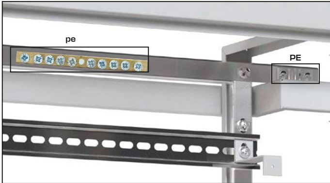
Обозначения: PE – место крепления магистрального кабеля заземления, pe – место крепления кабелей, отходящих в квартиры (где 1-8 – количество квартир).
